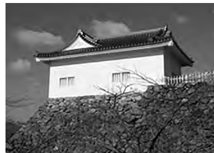
西三河の旗頭 石川家成の子孫が藩主を務めた伊勢亀山藩の亀山城 多門櫓(三重県亀山市)
