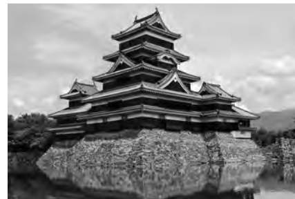
石川数正が築いた松本城(長野県松本市)
